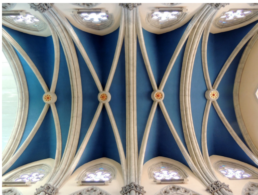
Restauración de las bóvedas de San Juan Bautista.
