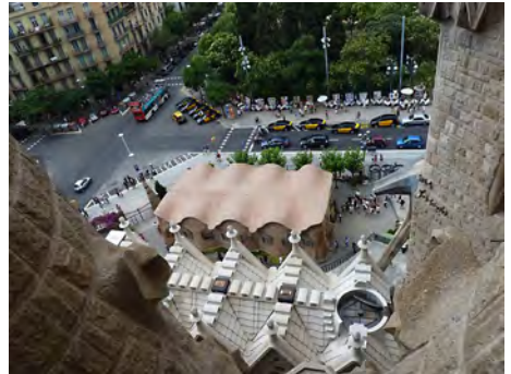
Vista de las escuelas para hijos de los obreros de la Sagrada Família.
